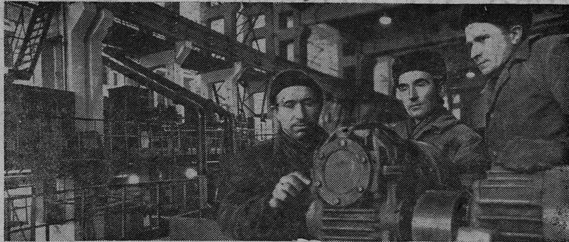
Кингисеппский комбинат «Фосфорит» вступает в строй. Он станет выпускать для колхозных и совхозных полей страны 840.000 тонн фосфоритной муки в год. Большой вклад в строительство пусковых объектов внесла бригада слесарей-монтажников Л. И. Ракова.
