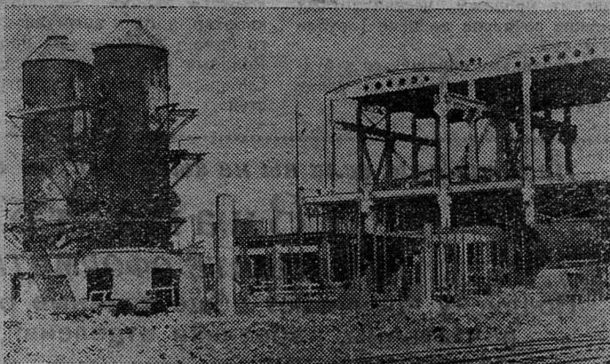
У строителей шестого управления и монтажников горячая трудовая пора. Они возводят технологические цехи Кингисеппского фосфоритного рудника, которые нужно сдать в эксплуатацию в конце пятого года семилетки.
