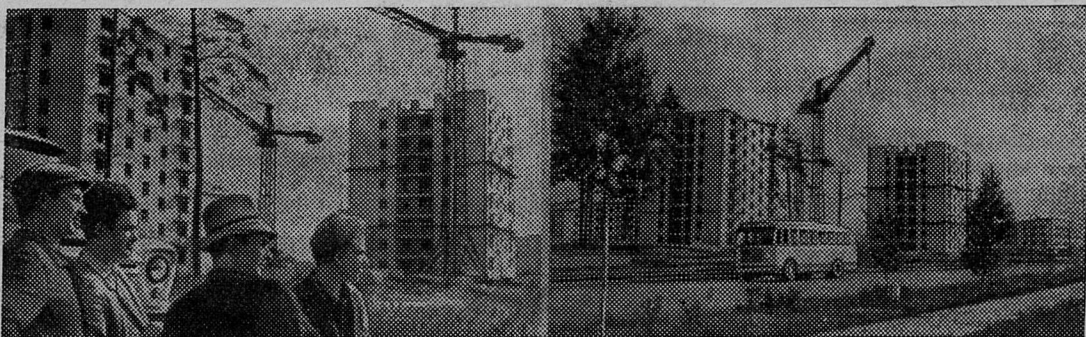
Городской пейзаж Свердловска украсился новыми современными зданиями. На проспекте Блюхера возводятся многоэтажные дома. В их отделке широко используются синтетические материалы, стеклопластики.
