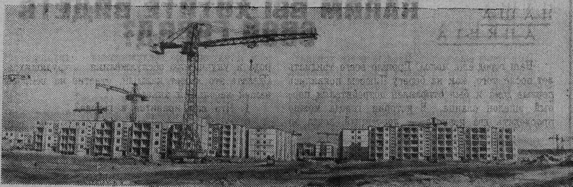
БАКУ. В северо-восточной части города ведется строительство нового жилого микрорайона. Детали зданий поставляет молодое предприятие республики — второй домостроительный комбинат. На снимке: строительство крупнопанельных домов в Восточном микрорайоне. Фотохроника ТАСС
