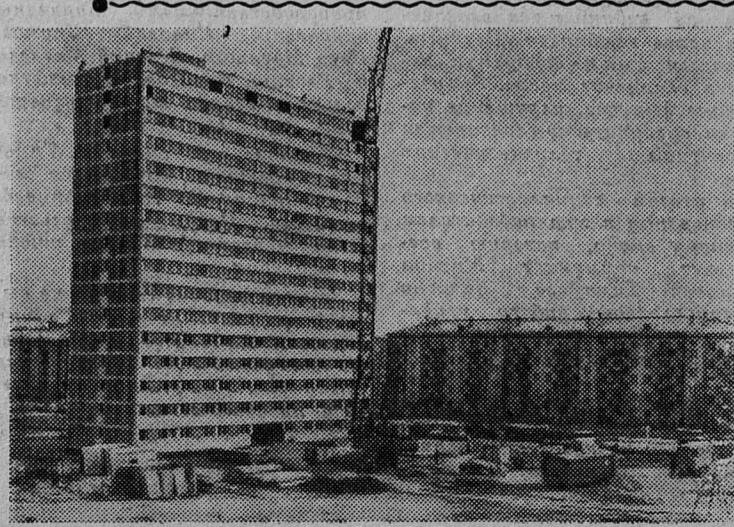
**МОСКВА.** В 10-м экспериментальном квартале Новых Черемушек закончен монтаж первого в Советском Союзе 16-этажного каркасно-панельного жилого дома. В здании 111 квартир, наружные панели дома облицованы стеклянной плиткой.
