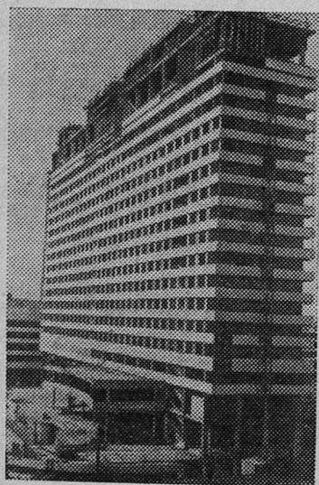
НА СНИМКЕ: 19-этажный корпус гостиницы «Советская» на Лермонтовском проспекте в Ленинграде.
