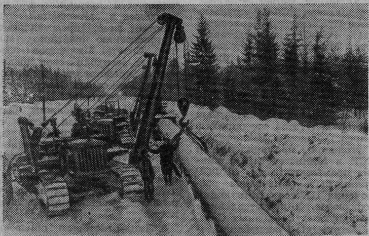
ЛЕНИНГРАДСКАЯ ОБЛАСТЬ. Развернулись работы на прокладке новой магистрали «голубого топлива» Белоусово — Ленинград. Пропускная способность ее в два с половиной раза превзойдет газопровод Серпухов — Ленинград. Строители треста Мосгазстрой в районе Тосно-Саблино уже проложили около 30 километров труб.
