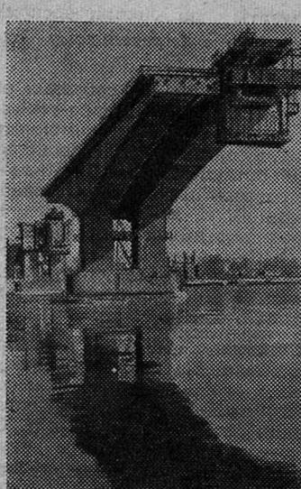
ЯРОСЛАВЛЬ. Успешно выполняет свои обязательства коллектив мостостроительства № 6, работающий на сооружении оригинального моста через Волгу. Строительство его ведется необычно. На берегу создана заводская площадка, где собираются огромные блоки. На них густо накладывают особый синтетический клей, а затем с помощью кранов блоки устанавливают на фермы и накрепко соединяют склеенные места.
