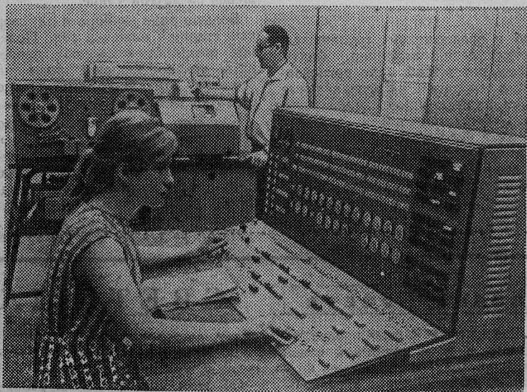
В вычислительном центре объединения «Электросила» имени С. М. Кирова установлена электронно-цифровая вычислительная машина «Минск-22». С помощью новой техники решаются сложные инженерные задачи по расчетам мощных турбо- и гидрогенераторов, крупных электрических машин, а также экономические задачи по планированию заводов объединенных цехов и участков.
