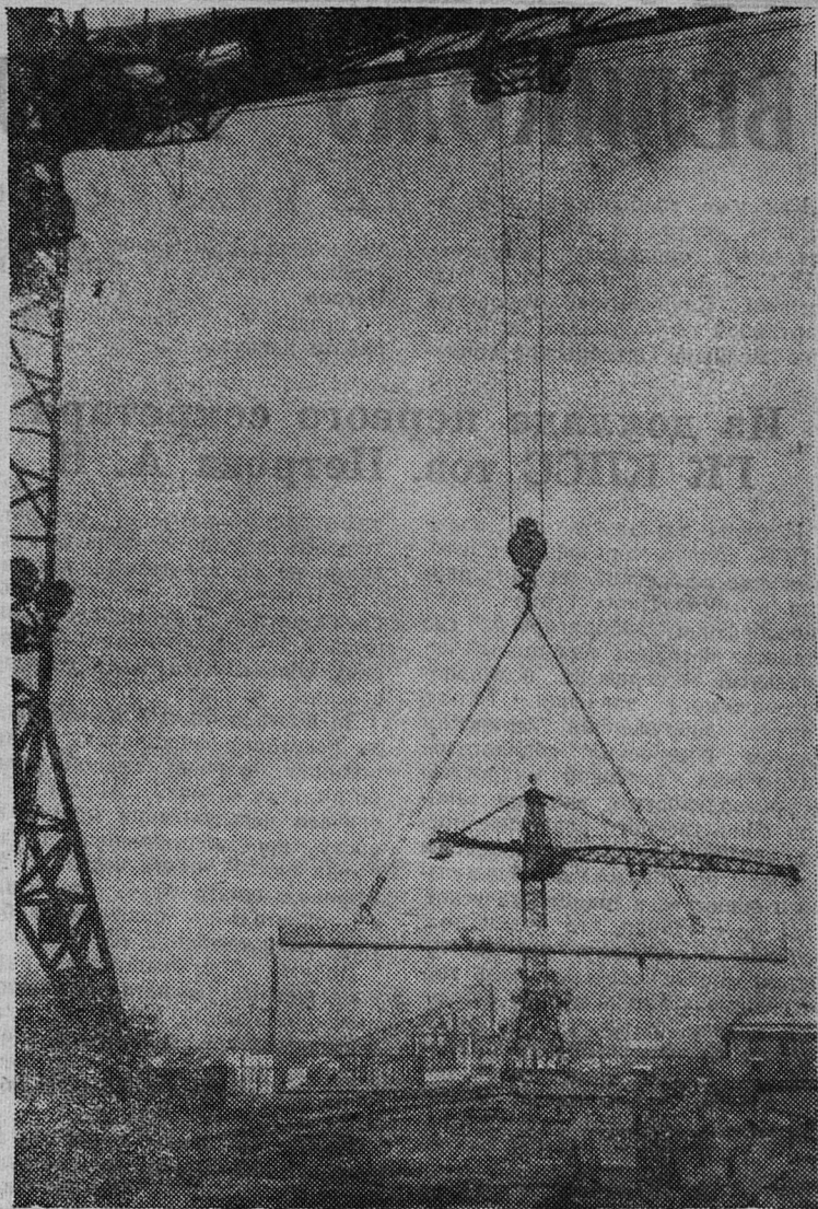
Из ворот комбината «Стройдеталь» ежедневно выходят автомашины, грузные карнизными плитами, блоками и другими изделиями, необходимыми для строек нашего города.
