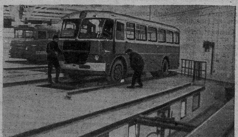
В Таллине сдан в эксплуатацию автобусный парк для 310 машин. В его главном механическом корпусе автобусы можно отремонтировать, вымыть, окрасить. На контрольно-пропускном пункте технический осмотр машин производится одновременно с заправкой горючим. Так как теперь отпадает необходимость в холостых переходах для заправки, то автобусный парк на этой операции сможет сэкономить до 200 тысяч рублей в год.
