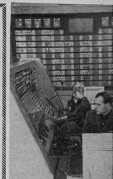
На Обуховском домостроительном комбинате в Ленинграде впервые в стране введена в эксплуатацию электронная установка «Ритм» — устройство для централизованного учета и оперативного управления производством. Эта установка автоматически ведет контроль наличия сборных элементов на складе на любой отрезок времени, за 3 дня сигнализирует о возможной нехватке той или иной детали из огромной номенклатуры, задает программу монтажа 10-ти единиц 2 типов и подает команду на своевременную поставку деталей.
