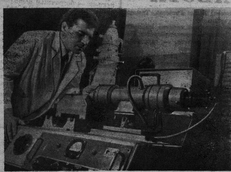
Автоматическая лазерная балансировочная машина, которая позволяет полностью уравновесить быстровращающиеся детали и роторы электрических машин, — одна из последних работ ученых Московского авиационного технологического института. Ее создали доктор технических наук профессор В. М. Суминов, кандидат технических наук А. К. Скворчевский и аспирант Б. Г. Кузин.
