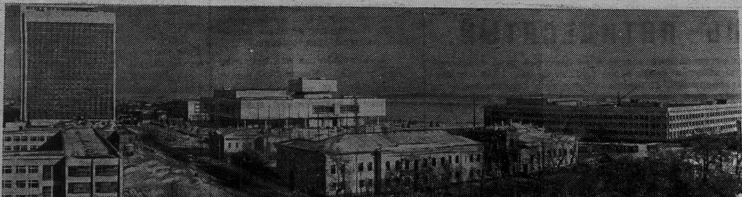
УЛЬЯНОВСК. Близится к завершению строительство Ленинской мемориальной зоны. Ударно трудится коллектив строителей, возводящий объекты величественного памятника вождю пролетариата.
