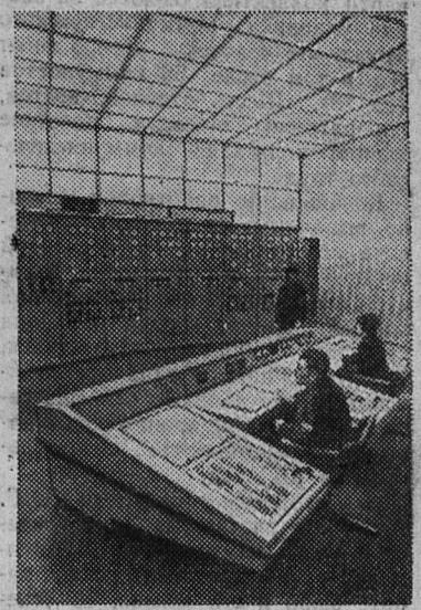
Красноярская ГЭС — крупнейшая в мире. В состав этого уникального гидротехнического сооружения на Енисее входит плотина длиной 1.100 и высотой 128 метров. Здание электростанции с десятью агрегатами мощностью по 500 тысяч киловатт каждый, открытое распределительное устройство в 500 тысяч и 220 тысяч вольт. Станция полностью автоматизирована. Управление электрическими машинами осуществляется с центрального пульта.
