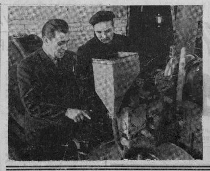
Имя конструктора Анатолия Михайловича Андреева хорошо известно коллективу ремонтно-механического вода. Он активный рационализатор на предприятии. Недавно по его чертежам здесь был изготовлен наплавочный станок, который намного ускорил процесс покрытия твердым сплавом деталей, подвергающихся в сильному износу. работе
