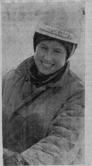
Сейчас строители ПМК-102 сооружают животноводческий комплекс в деревне Замощье — втором отделении совхоза «Старопольский». Особенно хорошо здесь трудится каменщик Ольга Васильевна Семина, которую и запечатлел наш фотокорреспондент во время работы.
