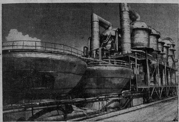
**Казахская ССР.** На побережье Каспия, в нескольких километрах от города Шевченко, сооружена атомная электростанция двойного назначения с реактором на быстрых нейтронах БН-350. Ее электрическая мощность — 150 тысяч киловатт, и одновременно за счет тепла, выделяющегося в ходе цепной реакции деления урана, можно получить 120 тысяч тонн опресненной воды в сутки.
