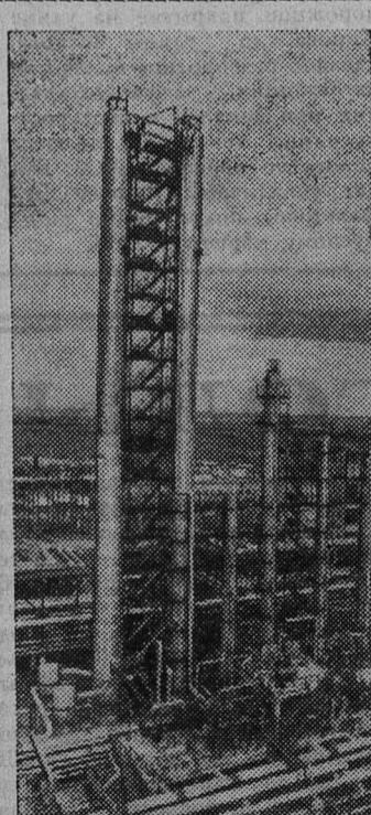
На Пермском нефтеперерабатывающем заводе вступили в строй первые промышленные объекты нового химического комплекса — печи пиролиза. В них начинается сложный процесс вторичной переработки нефти, в результате которого образуются продукты, являющиеся сырьем для получения научного, пластмасс.
