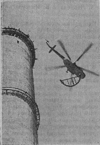
**МОСКВА.** На территории ТЭЦ № 23 строители «Энерговывотспецстроя» возвели самую высокую в столице 250-метровую трубу методом скользящей опалубки. Сейчас все монтажные работы завершены. Осталось снять с верхней части трубы около 40 тонн металлических конструкций и лесов, которые были необходимы при ее строительстве. Эту работу взяли выполнить авиаторы-вертолетчики под командованием пилота С. Н. Попова из аэропорта «Шереметьево».
