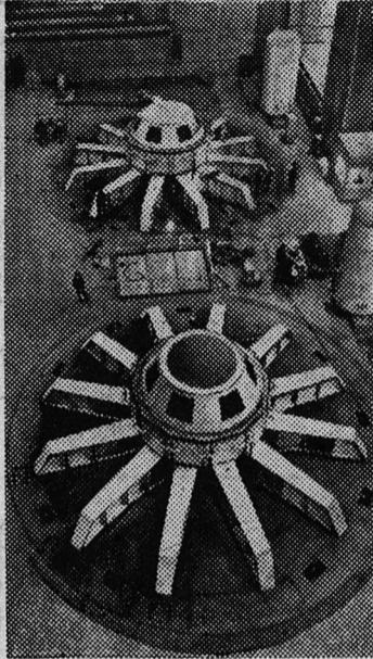
На крупнейшей в Киргизии Токтогульской ГЭС горячие дни. Завершается монтаж третьего и четвертого агрегатов мощностью 300 тысяч киловатт каждый, заканчивается укладка бетона в тело высотной плотины. Идет заполнение Токтогульского водохранилища. Гидроэлектростанция на Нарыне — ирригационно-энергетический объект. Руководство объемом 19 миллиардов кубических метров воды обеспечит гарантированное орошение 800 тысяч гектаров поливных земель и позволит освоить еще более 400 тысяч гектаров.
