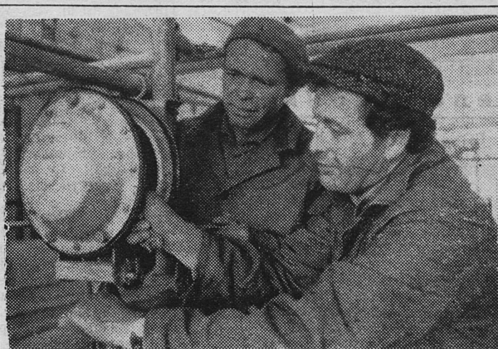
Скоро вступит в строй молочный комплекс на 1.200 коров в дер. Замощье совхоза «Старопольский». На монтаже оборудования хорошо потрудились бригада слесарей-монтажников Кингисеппской ПМК треста «Ленсельхозмонтаж».
