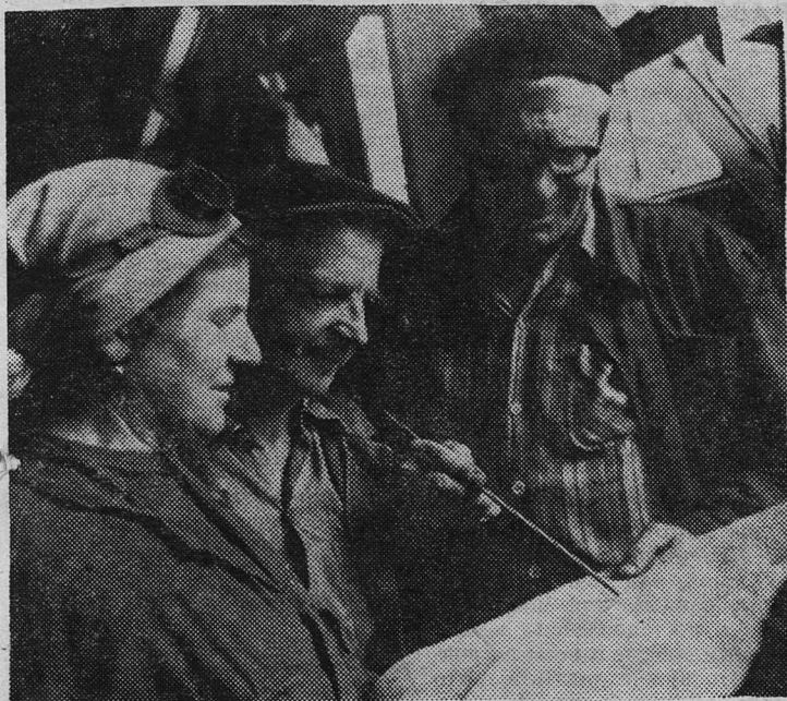
Высокими трудовыми показателями решил встретить XXVI съезд КПСС коллектив котельщиков из Северо-Западного СМУ треста «Связьметаллургомонтаж», который возглавляет А. М. Антонов. Сейчас бригада близка к завершению пятилетнего задания.
