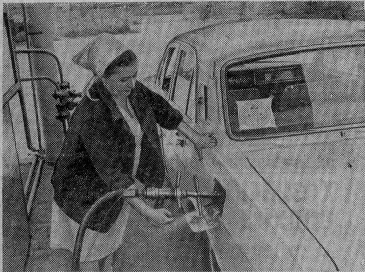
УЗБЕКСКАЯ ССР. 130 автомобилей ГАЗ-24-07 Ташкентского таксомоторного парка № 3 работают на сжиженном газе вместо бензина. Газовый баллон емкостью 84 литра устанавливается в багажном отделении. Его хватает на 450 — 500 километров пробега. Если в дороге кончится газ, водитель может продолжить движение на бензине. Переключение с одного топлива на другое занимает считанные минуты. Газ дешевле бензина.
