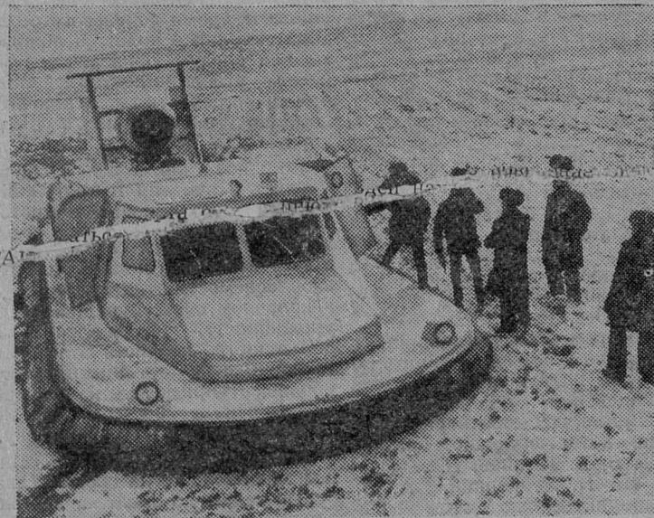
**ИОШКАР-ОЛА.** Над созданием комплекса транспортных и транспортно-технологических машин на воздушной подушке, предназначенных помочь людям при строительстве и обслуживании газопроводов на болотах, работает СКБ Мариинского политехнического института имени А. М. Горького. Конструкторы разрабатывают автобус для скоростной перевозки людей и срочных грузов независимо от погодных условий, а также самоходные платформы грузоподъемностью десять и пятьдесят тонн.
