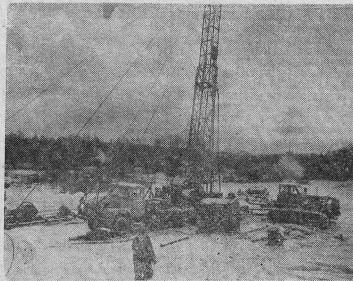
Представьте мысленно колодец диаметром около двух метров и глубиной сто два метра — вот такие дырки бурят со своей бригадой Николай Иванович Машустин. Последняя их работа — вентиляционная скважина и артезианский колодец для питьевой воды в поселке третьей шахты. За год — две-три скважины. 1,5—2 метра, пройденных в сутки, считаются хорошим результатом.
