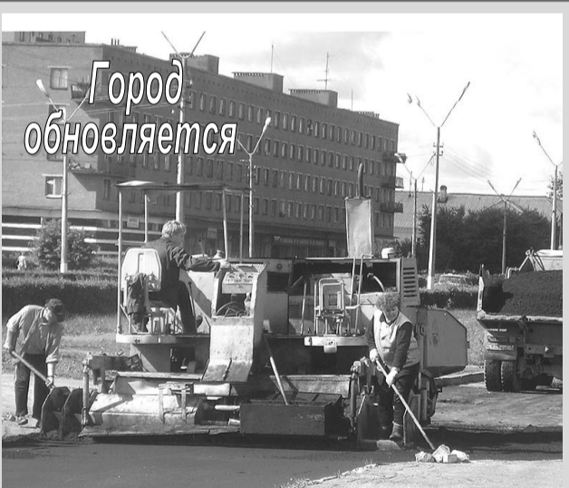
Быстро и качественно коллектив ГП «Сланцевское ДРСУ» отремонтировало асфальтовое покрытие дороги от магазина «Никольский» до рынка на ул. Ленина.
