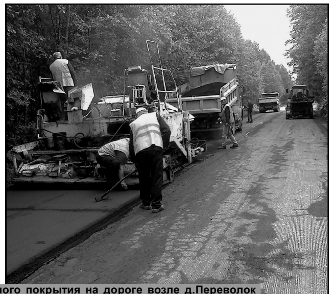
Восстановление асфальтобетонного покрытия на дороге возле д.Переволок
