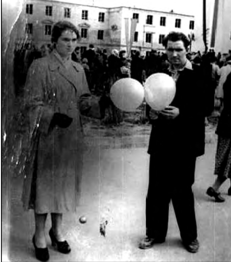
Галина Кузнецова и Виктор Готовчиков. Идёт строительство ул. Свердлова. 1-е мая 1959 года
