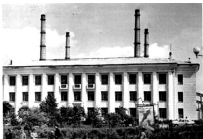
Здание заводоуправления спз «Сланцы»
