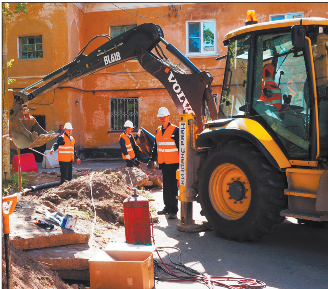
Нынешним летом филиал ЗАО «Нева Энергия» проводит масштабную подготовку тепловых сетей к работе в осенне-зимний период в микрорайон Лучки. На снимке: идут работы на ул. Маяковского
