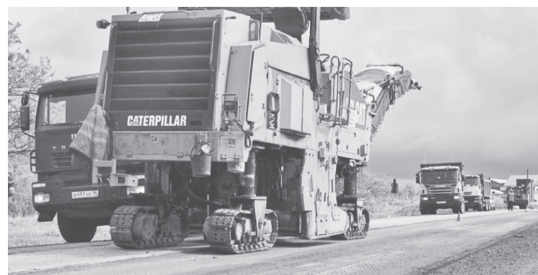
Дорожные работы на региональной трассе Лудейное Поле — Тихвин — Будогощь в Тихвинском районе
